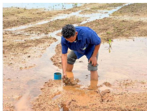
เกษตรกรกลุ่มเป้าหมายปฏิบัติติดตั้งท่อส่งกระดับน้ำ(AWD pipe) ในแปลงนา เพื่อใช้เป็นเครื่องมือกำหนดช่วงปล่อยน้ำแห้งและปล่อยน้ำเข้าใหม่
