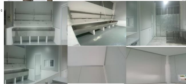
ภาพที่ 3.7 อาคารผลิตหลังปรับปรุง
