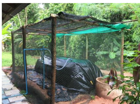
ภาพที่ 4 บ่อแก๊สชีวภาพระดับครัวเรือนด้วยถุงพลาสติก LDPE
