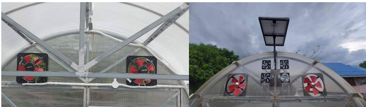
ภาพที่ ( 3 ) พัดลมระบายความชื้น ขนาด 5 นิ้ว 2 ตัว และ 10 นิ้ว 4 ตัว
