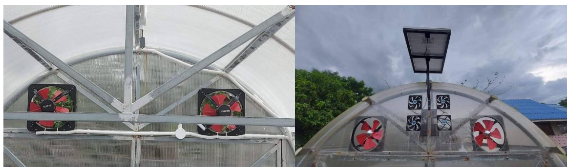
ภาพที่ ( 32 ) พัดลมระบายความชื้น ขนาด 5 นิ้ว 2 ตัว และ 10 นิ้ว 4 ตัว
